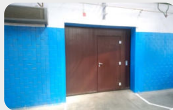
ОАО «Минский электротехнический завод имени В. И. Козлова», Минск Автоматические откатные противопожарные ворота «ФаерДорс» с калиткой
