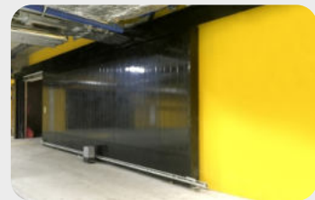
ТРЦ «Галерея Минск», Минск Противопожарные откатные ворота «ФаерДорс» Ei60
