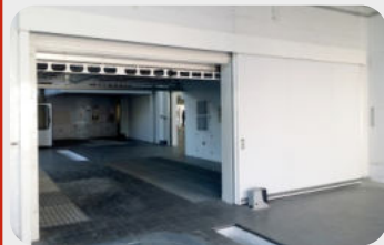
Автомобильный центр «Renault», Минск Противопожарные откатные ворота «ФаерДорс» Ei60
