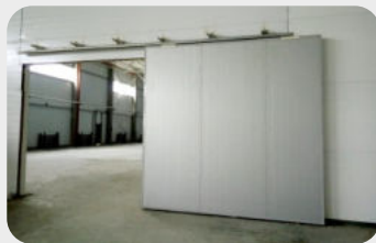
Завод «Амкорор-Эластомер», Минская область Противопожарные откатные ворота «ФаерДорс» E160
