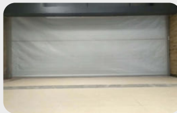
Торгово-развлекательный центр «Кристалл», Гомель Автоматические противопожарные шторы с орошением «ФаерДорс» Ei120
