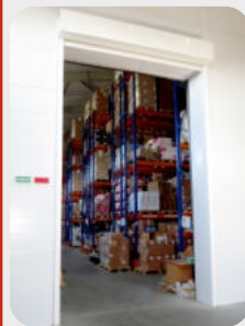
Логистический центр «ЕврАзия», Минская область Противопожарные шторы «ФаерДорс» E120
