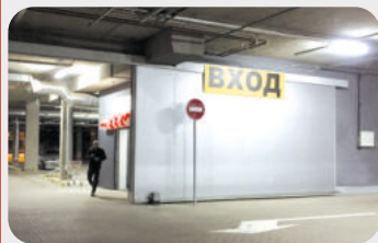
Торговый центр «Outleto», Минск Противопожарные ворота откатные «ФаерДорс» Ei60
