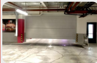
ТРЦ «Moskva», Алматы, Казахстан Противопожарные шторы «ФаерДорс» Ei120
