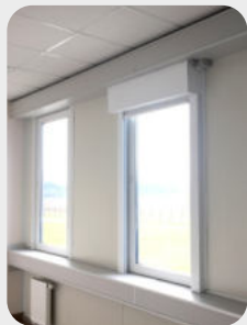
ООО «Велес-Мит», Минская область Противопожарные шторы «ФаерДорс» E60
