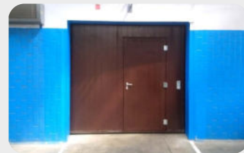
ОАО «Минский электротехнический завод имени В. И. Козлова», Минск Автоматические откатные противопожарные ворота «ФаерДорс» с калиткой
