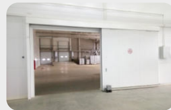
Завод «Ферролибел», Минский район Противопожарные откатные ворота «ФаерДорс» Ei60
