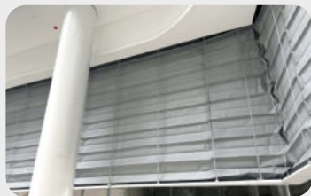
Торгово-развлекательный комплекс «Minsk City Mall», Минск Автоматические дымозащитные шторы аккордеонного типа «ФаерДорс»
