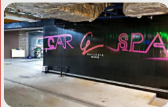
ТРЦ «Галерея Минск», Минск Противопожарные откатные ворота «ФаерДорс» Ei60
