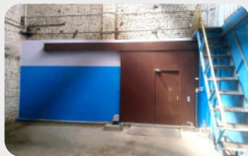
ОАО «Минский электротехнический завод имени В. И. Козлова», Минск Автоматические откатные противопожарные ворота «ФаерДорс» с калиткой
