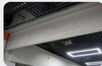
Торговый центр «Карусель», Бобруйск Противопожарные шторы «ФаерДорс»
