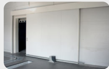
Автомобильный центр «Renault», Минск Противопожарные откатные ворота «ФаерДорс» Ei60
