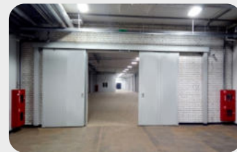
Склад автозапчастей «MotorLand», Минск Противопожарные откатные ворота «ФаерДорс» Ei60
